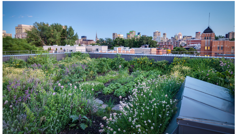
Casse tête : Rayside-Labrossière. Green roof
