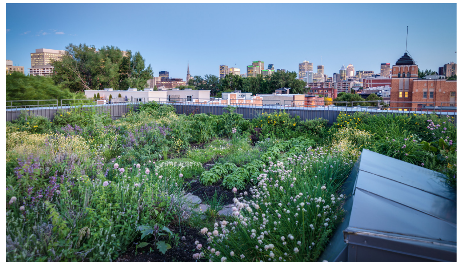
Casse tête : Rayside-Labrossière. Toiture végétalisée.
