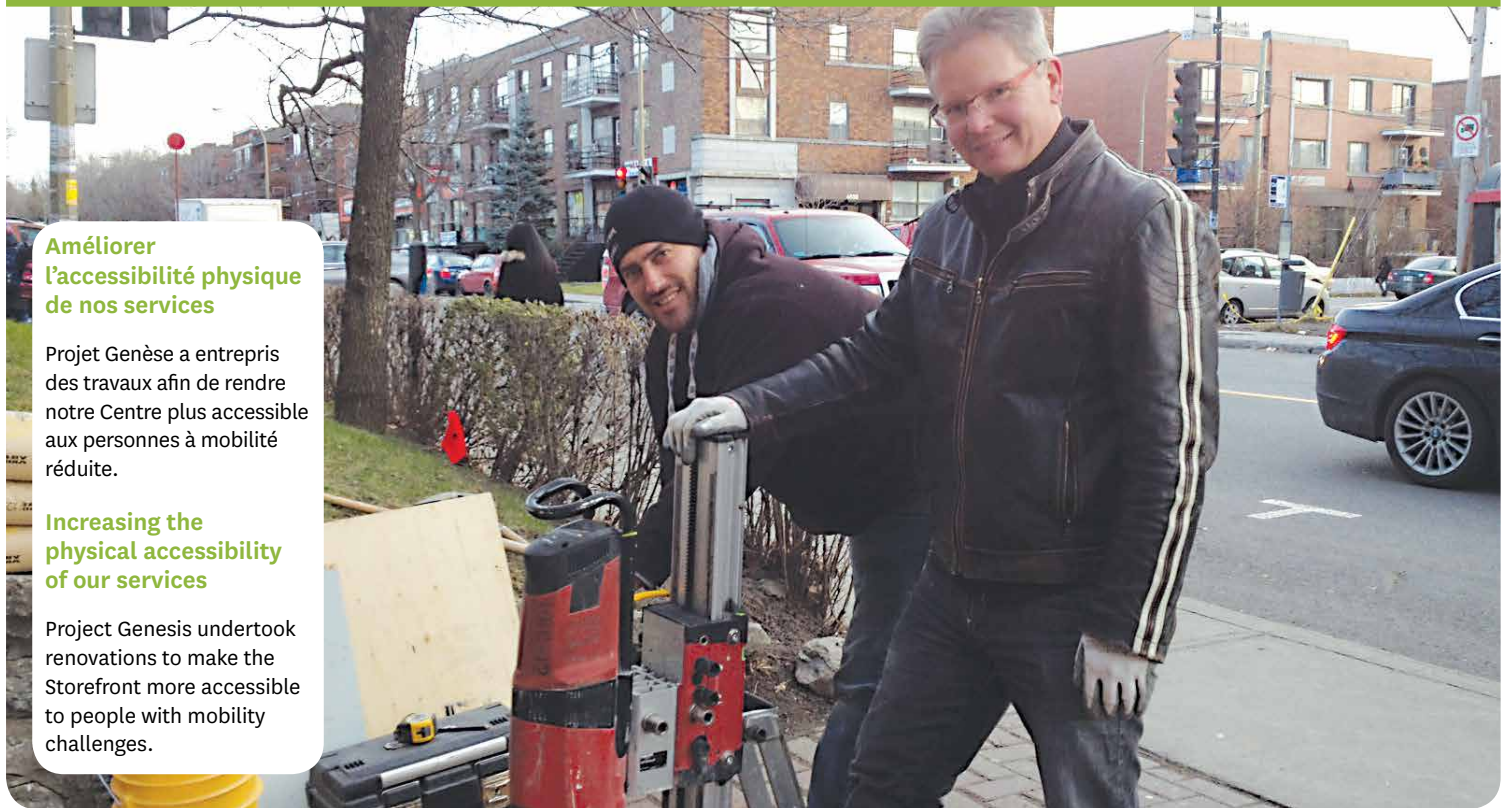
L'installation d'une rampe à l'extérieur du Centre de services individuels. The installation of an accessibility handrail in progress outside the Storefront.
